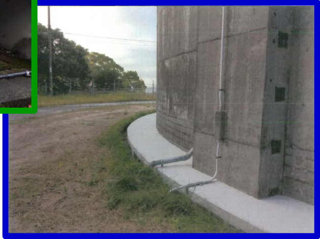
西ヶ丘配水池 (1号)
