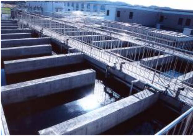
広瀬浄水場（着水井）
