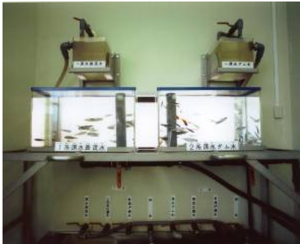
広瀬浄水場（毒物監視用水槽）
