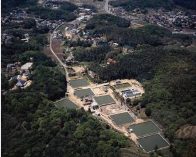
中山浄水場（全景）
